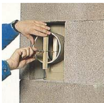
11. A füstcsőkarimát a kerámia csőhöz csavart huzallal rögzítjük.
